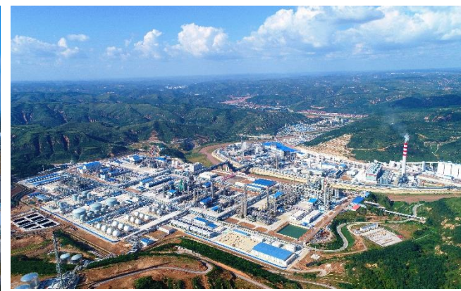
延安油气煤综合利用项目
